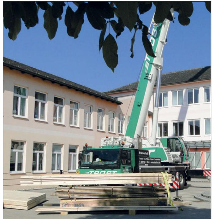
*Start der Umbauarbeiten - Spektakuläre Montage eines Zubaus. - Am 22. Mai kamen die Um- und Zubauarbeiten in der NMS und PTS Grafenegg richtig in Schwung. Für Jedermann sichtbar hob ein riesiger Kran Holzelemente über die Schule, die im schwer zugänglichen Bereich an der Rückseite des Gebäudes zu einem zweistöckigen Toilettentrakt zusammengebaut wurden. Aus Rücksicht auf den Schulbetrieb wurde bis spät am Abend gebaut und so konnte am Mittwoch unterrichtet werden, als wäre nichts geschehen!*
